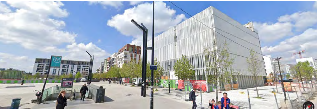
Centre de colloque
