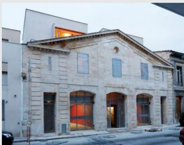
Fig.252 Façade de l'ancien entrepôt conservée, architecte : Bernard Bühler, photos : Vincent Monthiers (RÉHABILITATION D'UN ENTREPÔT EN 20 LOGEMENTS À BORDEAUX)
