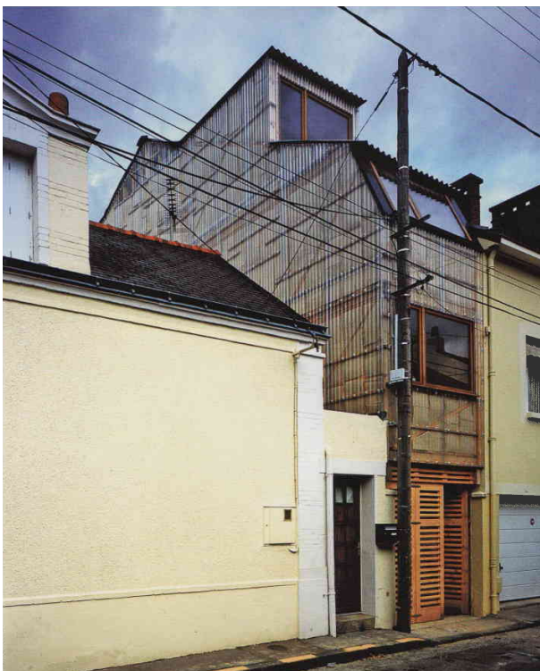
Fig.201 Extension de maison dans une dent creuse, architecte : Xavier Fouquet, photo : Philippe Ruault (DARMON, 2011, p.51)
