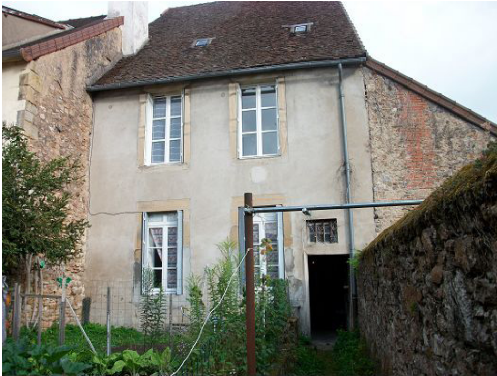
Fig.183 Maison de ville à Autun (photo : http://www.trouver-un-logement.com/annonce-immobiliere-autun-f49o.htm )
