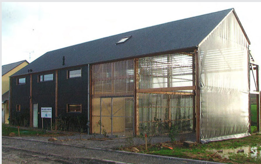
FIG.276 Maison de constructeur évolutive, architectes : C. Gaudoin, A. Morin, photo : CIL 53 (DARMON, 2007, p.18)
