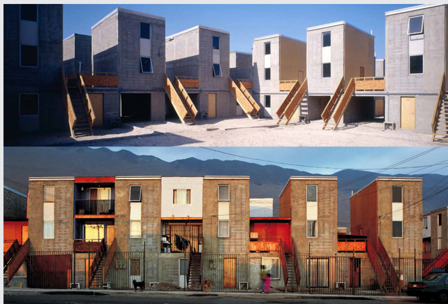
Fig.271 Quinta Monroy avant et après modifications par les habitants, photos : Elemental, Tomas Cortese (QUINTA MONROY)
