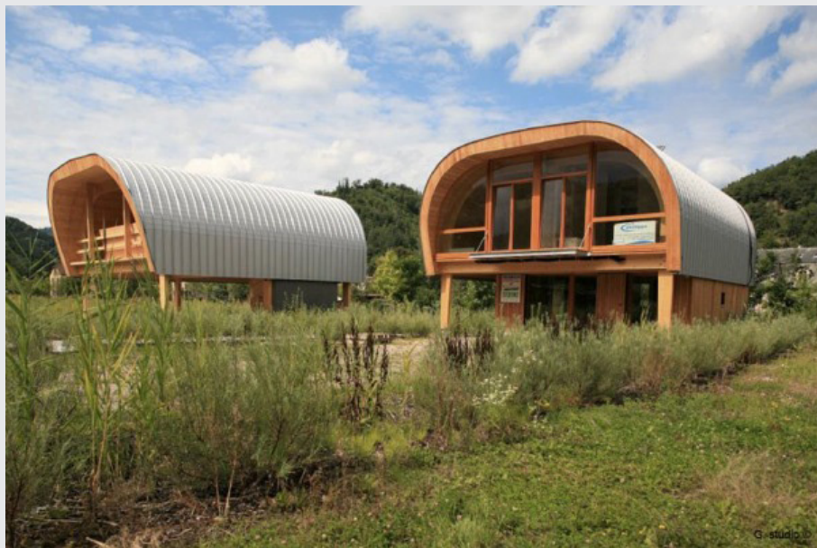
Fig.274 Premières réalisations du « lotissement des coccinelles », architectes : G Studio, photo : G Studio (DER MADIROSSIAN, VAUTRIN, CERTU, ET AL., 2011, p.73)
