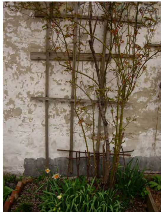
Photo 91 : À l'est du CCG, le mur de l'immeuble adjacent sert à faire grimper des rosiers, avril 2007.
