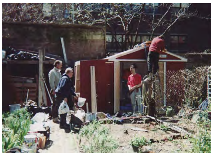
Photo 105 : Construction d'une nouvelle cabane à outils au Clinton Community Garden, 1998.
