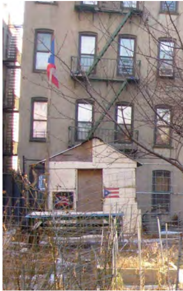
Photo 85 : L'ancien abri à outils, février 2007.
